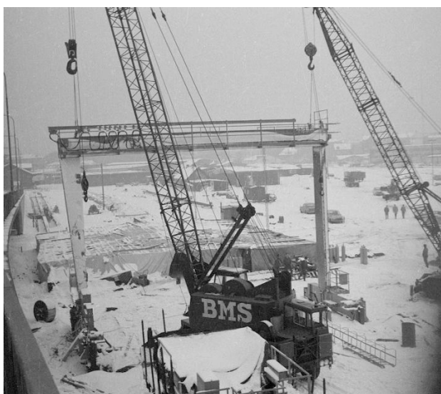
Opsætning af kranen i Aalborg Januar 1970 Foto: Martin Jacobsen, Aalborg
